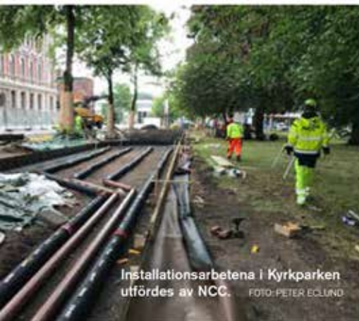
Inledande arbeten med installation av Savaq-systemet i Kyrkparken i Skövde. FOTO: PETER ECLUND
