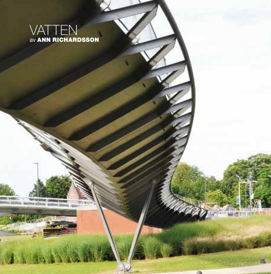
Gång- och cykelbron "College Bridge" designad av Laurent Ney är iögonfallande.
